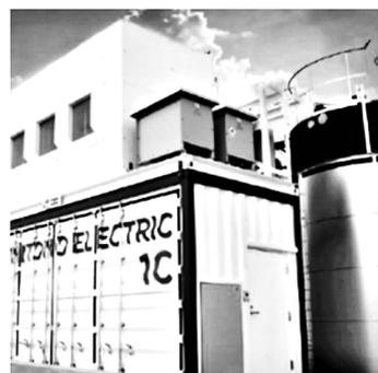
レドックスフロー電池の外観(住友電気工業ホームページより)
